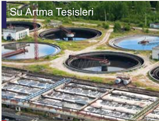
Su Arıtma Tesisleri
